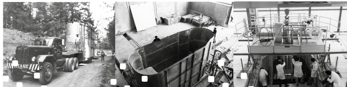
Llegada e instalación de la vasija del reactor.
